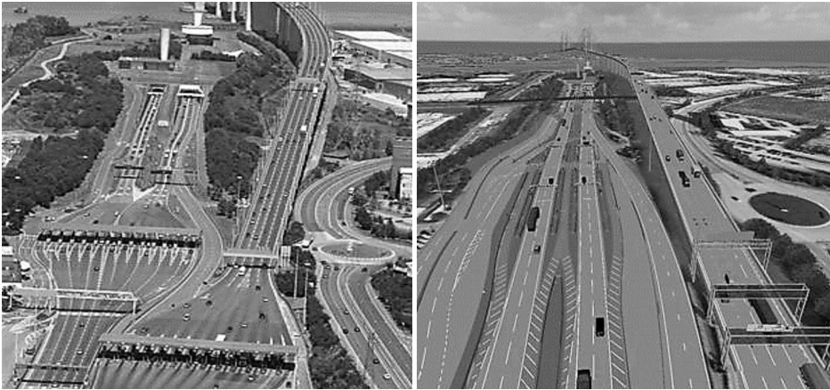
Rysunek 2. Dartford Crossing London. Tradycyjny system poboru opłat na bramkach (z lewej strony) oraz system zdalny eliminujący potrzebę płatności manualnych
